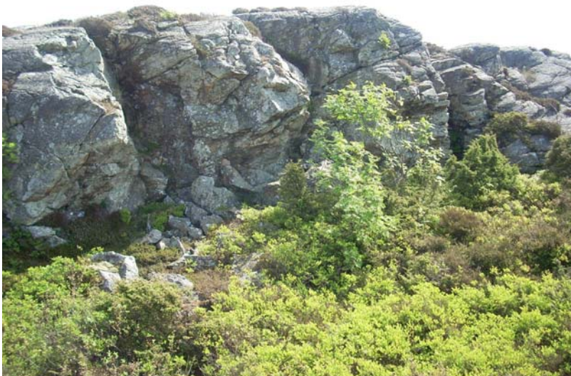
Brant bergvägg ned mot ravin i västra delen av bergsområdet.
