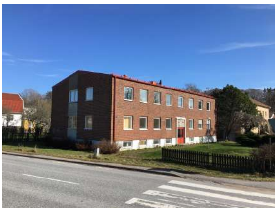
Läkarvägen 1, sett från Kyrkvägen. En mindre grönyta finns mellan hus och parkering.
