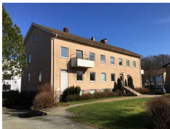
Läkarvägen 3. Befintlig byggnad som ska ersättas med trygghetslägenheter, sett från Läkarvägen.
