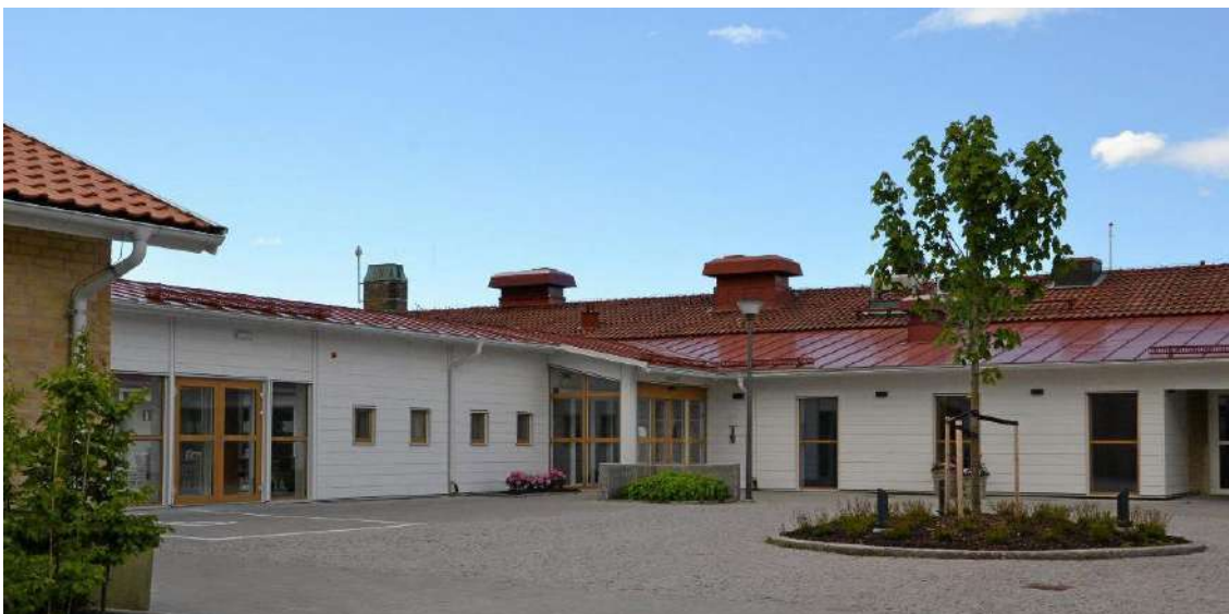
Det nyligen iordningställda entréorget. Ingång till Stångenäshemmet centralt i bild.
