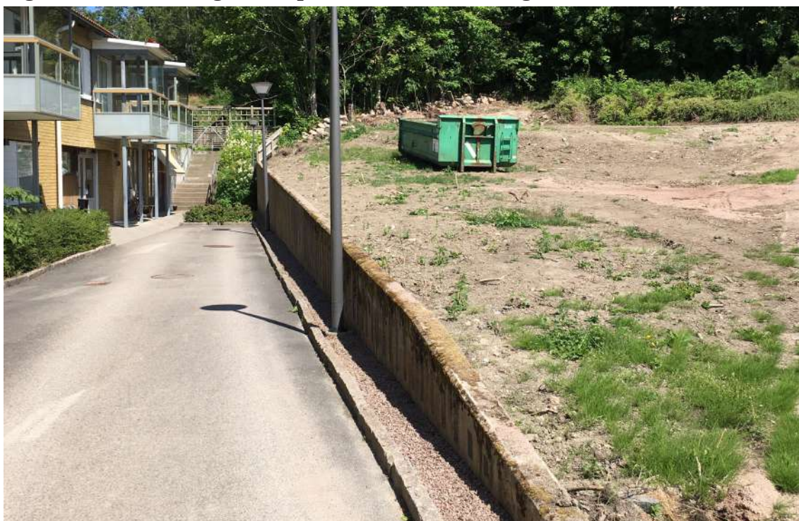
Marknivåskillnad och stödmur (L-stöd) i områdets östra del. Befintlig stödmur bevaras.
