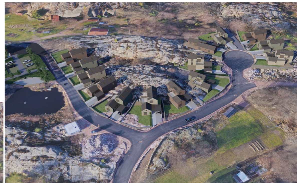
Översiktsvy mot väster
