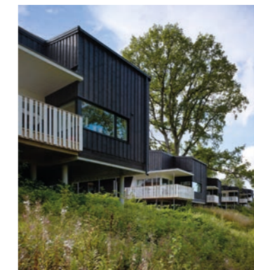
Referens: Plintgrundläggning Årlevägen
