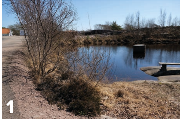
Vid platsbesök upplevdes dammen som en orörd, lugn plats med sin tätare vegetation och sin vattenspegel.
