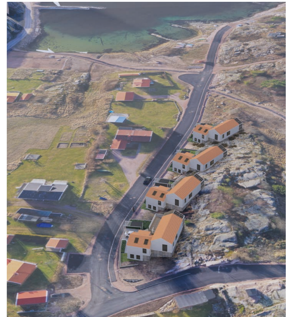
Översiktsvy mot sydväst
