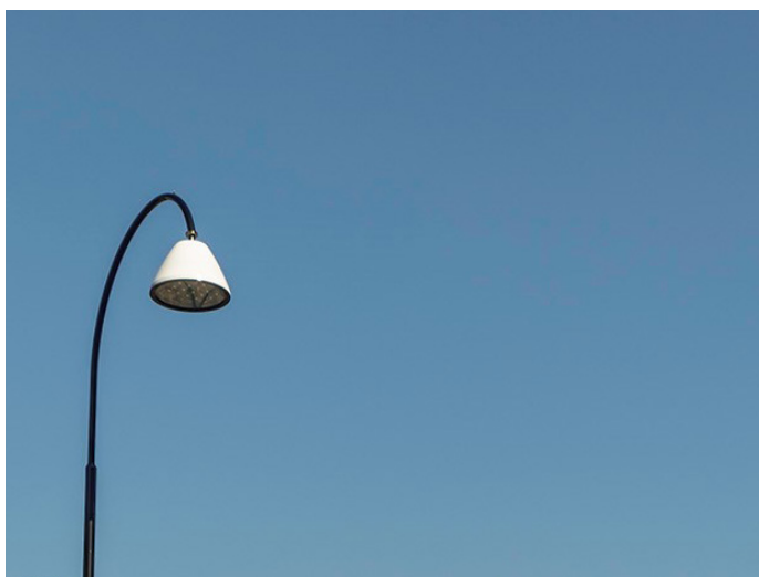
Typutformning av böjd stolpe och armatur längs med gator inom karaktärsområde 1. Armaturen finns längs med Rosviksgatan.
