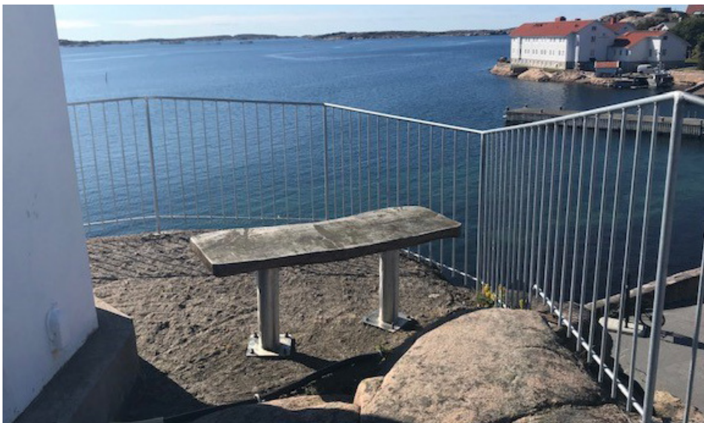
Ett diskret nytillverkat handsmitt räcke på Carlaberget i Lysekil. Räckets uppfyller alla krav på säkerhet enligt Boverkets byggregler.
